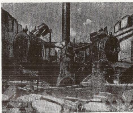
Взорванная котельная депо Сталиногорской железной дороги.
